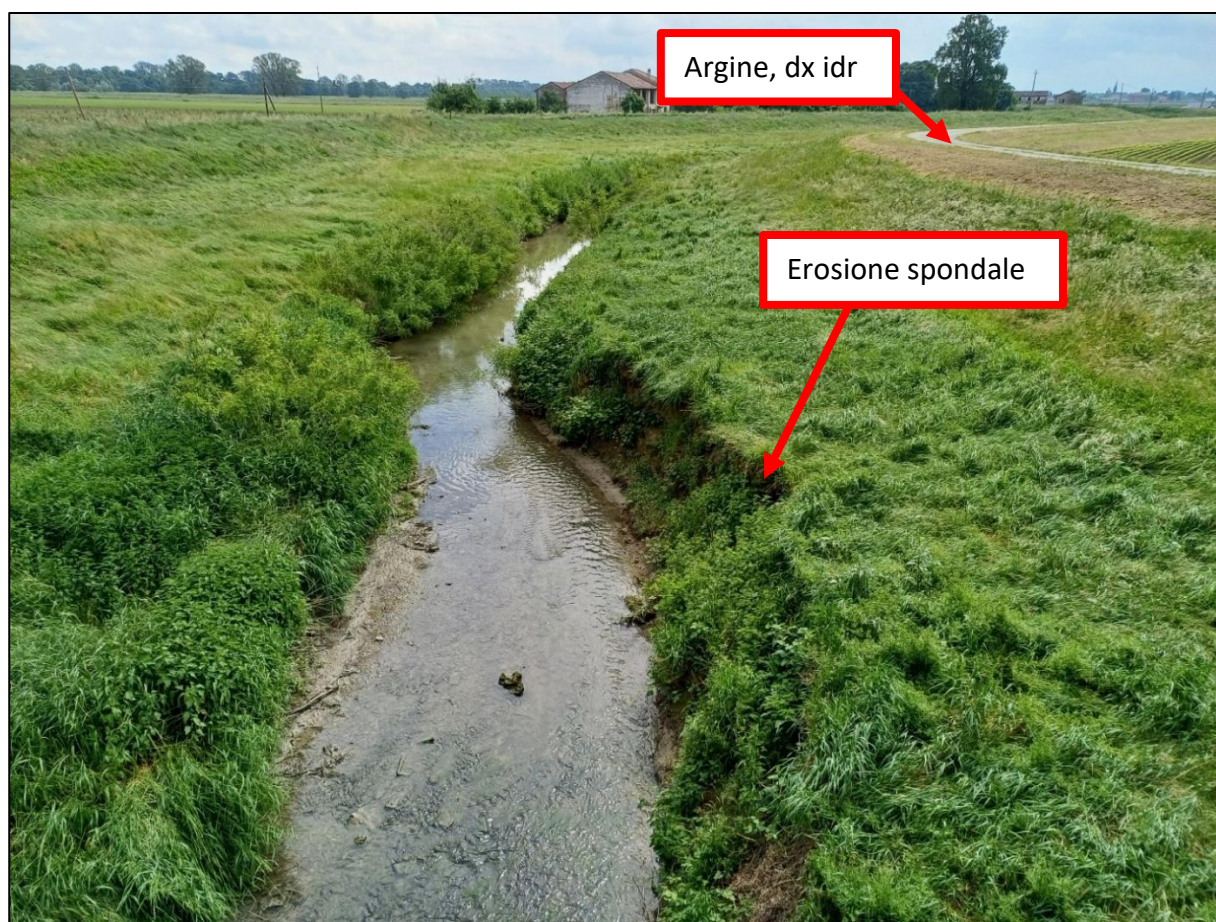
Figura 9 – Fontana – Sistemazione erosione spondale.
