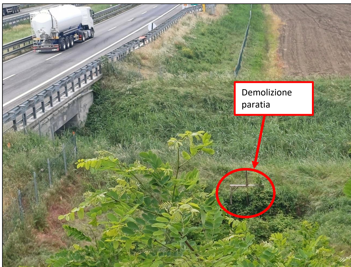
Figura 1 – Scovalasino – Demolizione paratia esistente ed installazione nuova tubazione in CLS con valvola clapet.
